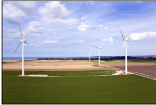
Parc éolien de Veulettes-sur-Mer
