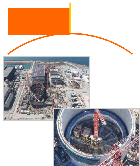
Chantier EPR de Flamanville 3
